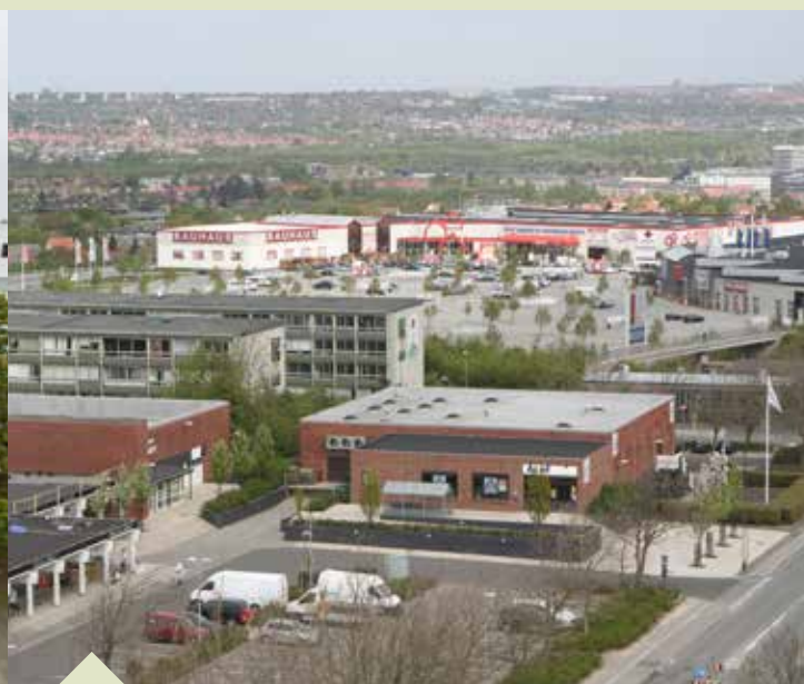
Eksisterende bygninger, inklusiv tankstation nedrives (arkivfoto)
